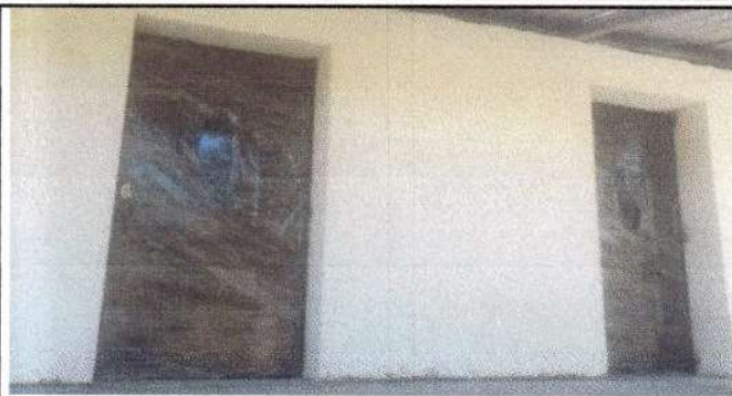
Foto 7: Finalización de instalación de puertas de metal en módulos.
