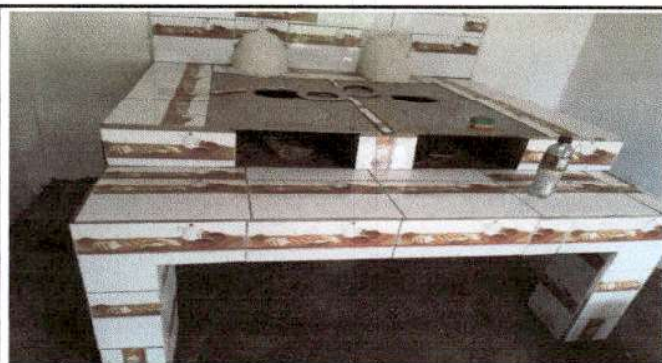
Foto 9: Finalización de sustitución de estufa rural (completa) incluye chimena y plancha de metal.
