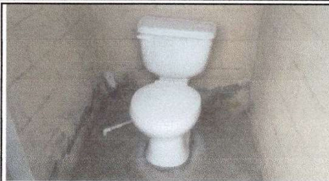
Foto 8: Finalización de sustitución de inodoro
