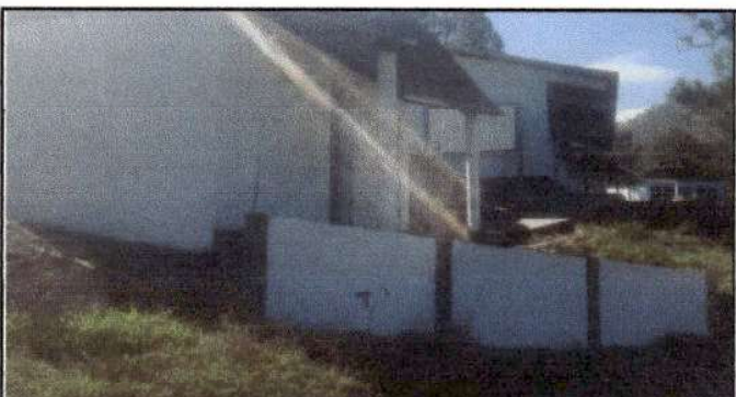
Foto 10: Finalización de repello en muro.
