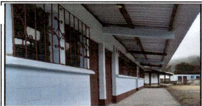
Foto 5: Finalización de fabricación e instalación de balcones de hierro en ventana.
