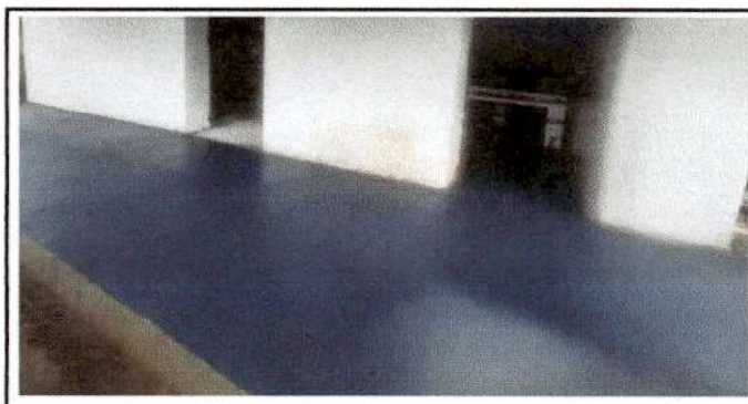
Foto 4: Finalización de sustitución de piso de torta de concreto 10cm de grosor.
